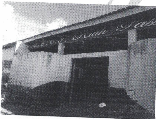
Pintura geral do muro e grades
